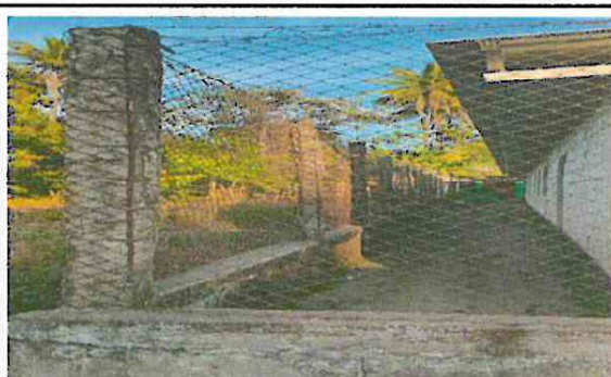
Foto 2: Reparación Muro Perimetral parte exterior
