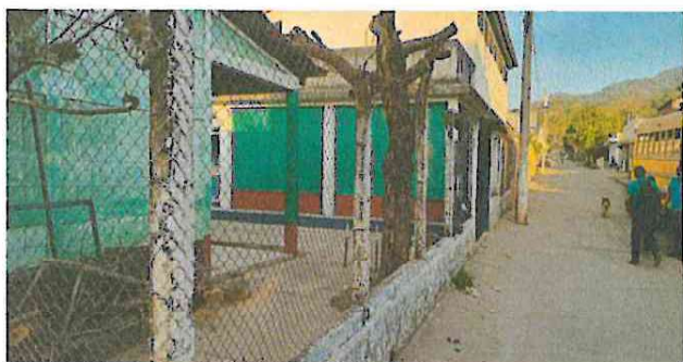
Foto 3: Reparación Muro Perimetral parte exterior
