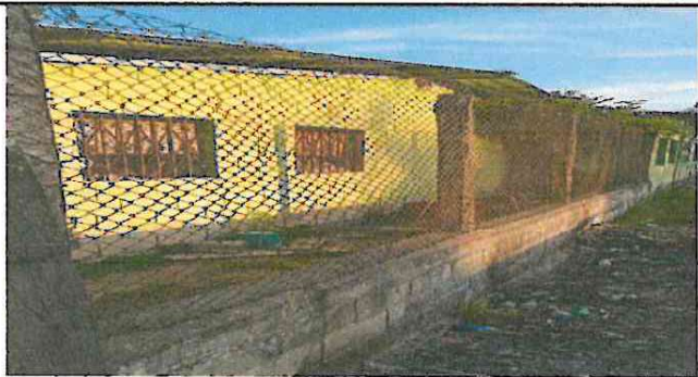
Foto 1: Reparación Muro Perimetral parte exterior
