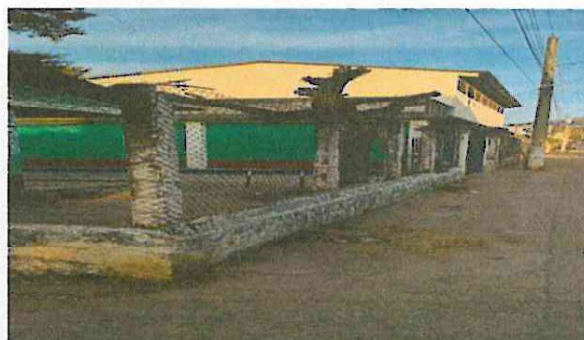
Foto 4: Reparación Muro perimetral parte exterior
